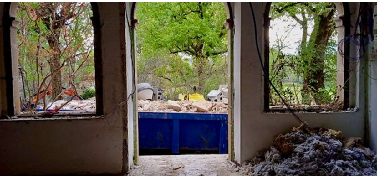
Future entrée du premier appartement
