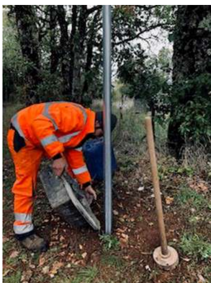
Après avoir accentué l'enfoncement à l'aide d'une masse, Brice verse une auge de ciment pour maintenir le poteau.
