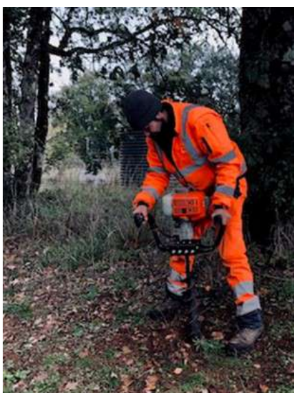
La taraudeuse n'a pas été toujours facile d'emploi, par exemple en bordure de mur, trop de cailloux !
